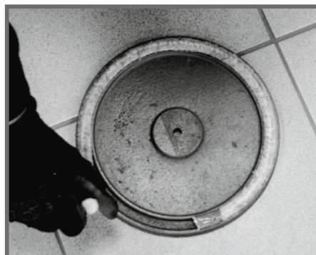
Fot. Wymiana sznura uszczelniającego.
